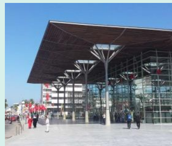
Nouvelle gare Casa port
