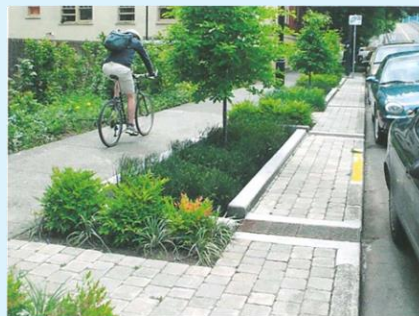
Noues de gestion des eaux pluviales ruisselant de voiries et des trottoirs - Portland
