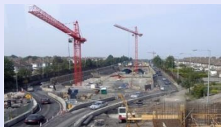
Travaux entrée de Casablanca
